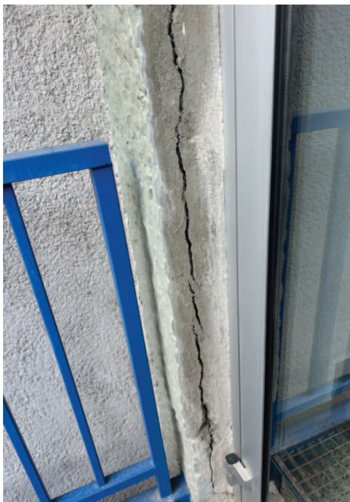
jižní fasáda - vedlejší vstup, defekt obkladu
