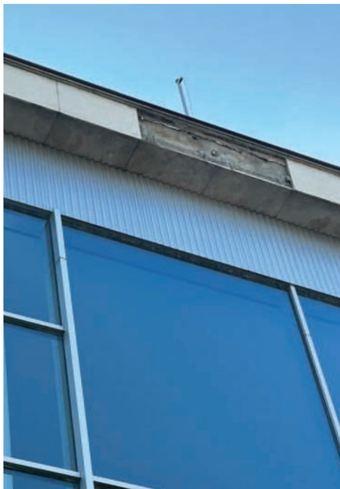
západní fasáda - deformace obkladu
