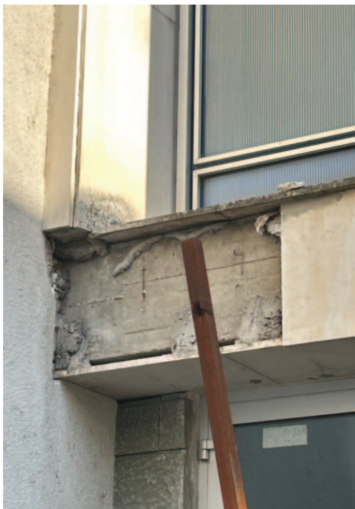
jížní fasáda - defekt obkladu nad vedlejší vstupem
