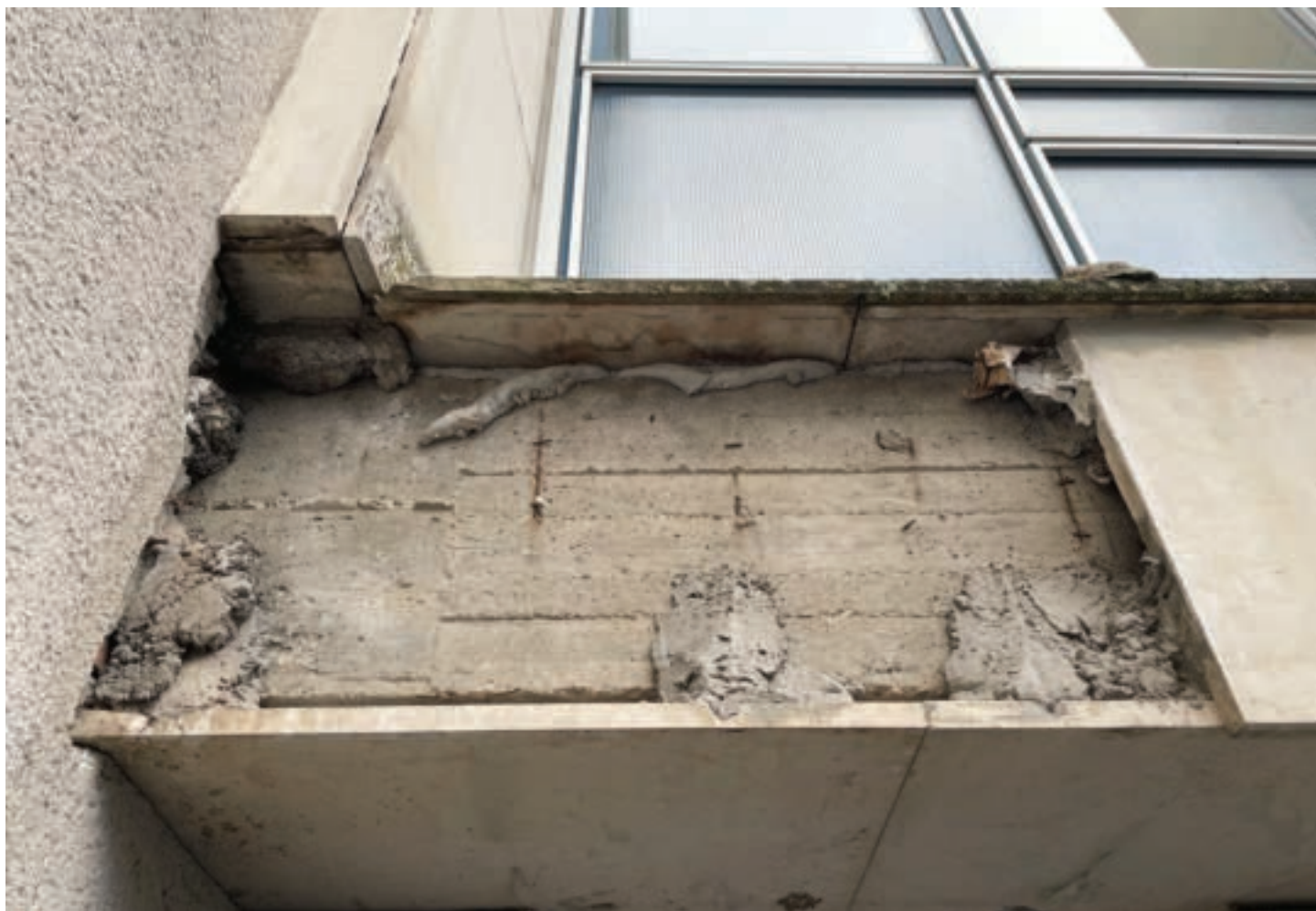
jížní fasáda - defekt obkladu nad vedlejší vstupem
