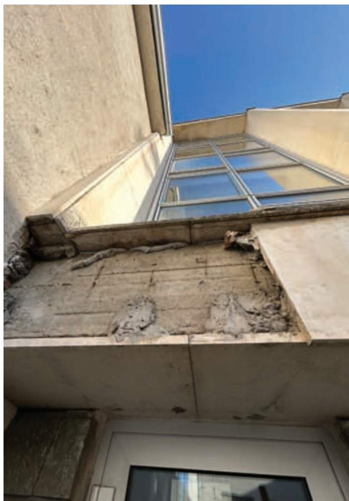
jížní fasáda - defekt obkladu nad vedlejší vstupem
