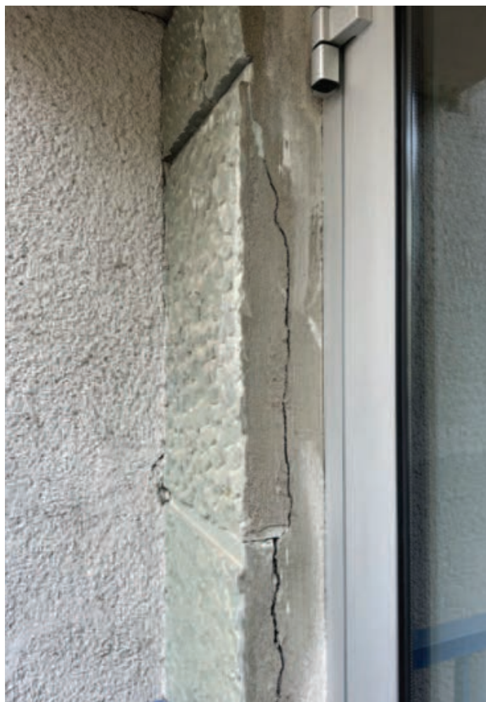
jižní fasáda - vedlejší vstup, defekt obkladu
