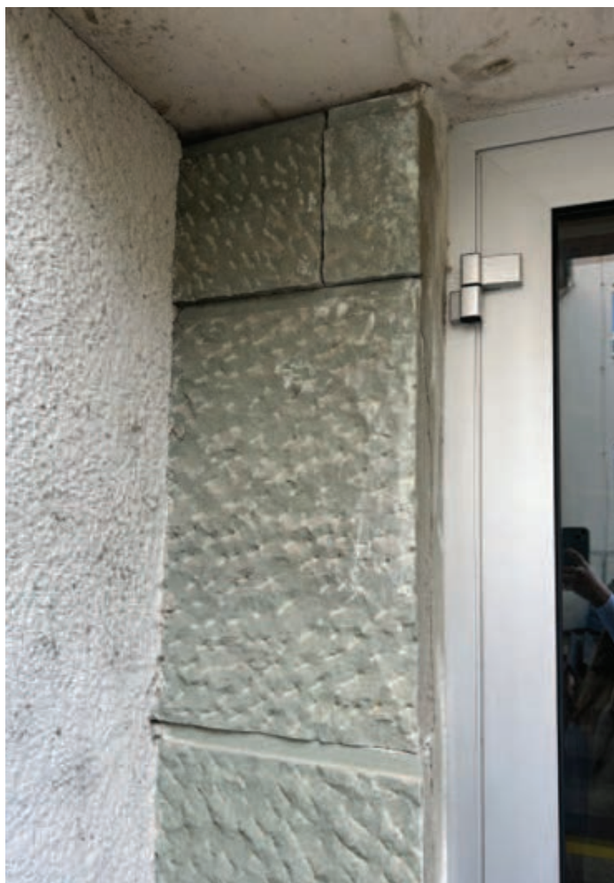
jižní fasáda - vedlejší vstup, defekt obkladu
