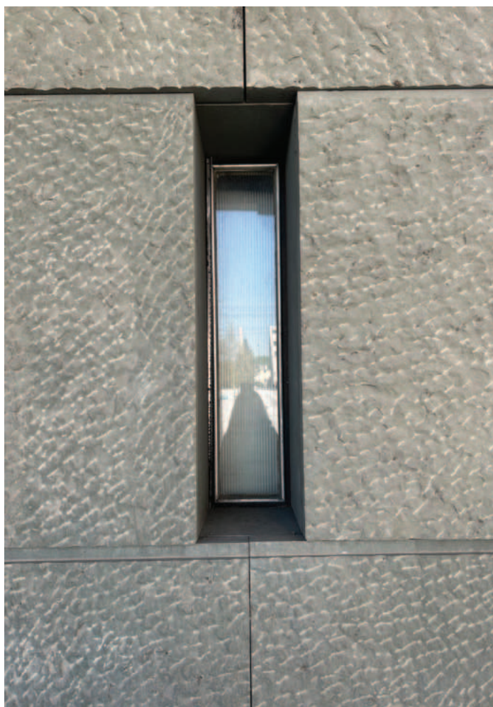
původní okno 1.NP, obklad slezský pískovec
